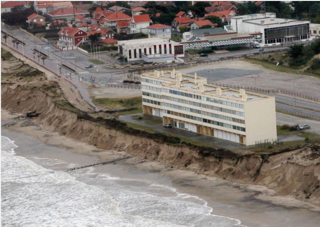
L'immeuble Signal, à Soulac-sur-Mer, le 5 janvier 2014. Laurent Theillet
