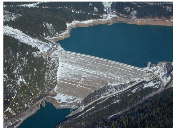
Barrage de Mica au Canada, haut de 243 mètres.
